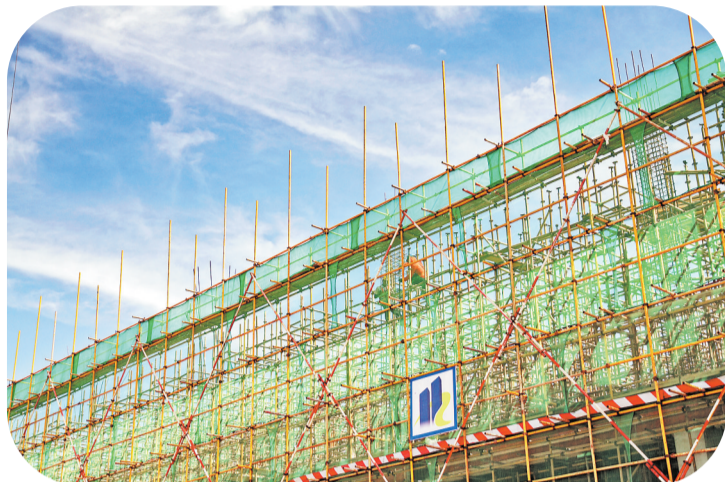
新雨丹中药材科技产业园二期项目建设现场
