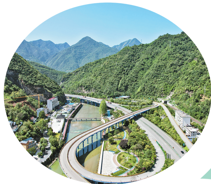
镇安县北门口区改造提升项目
