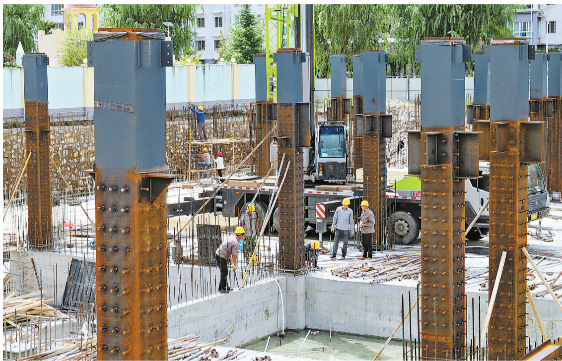
连日来,丹凤县天麻交易中心正在加紧建设。据了解,该天麻交易中心位于丹凤县杏庄镇街坊村文化广场东侧,总占地一点零五万平方米,建成后是集检验检测、生产加工、线上交易、线下交易等于一体的天麻交易中心,助力乡村振兴。(本报通讯员 王盈琳 摄)
