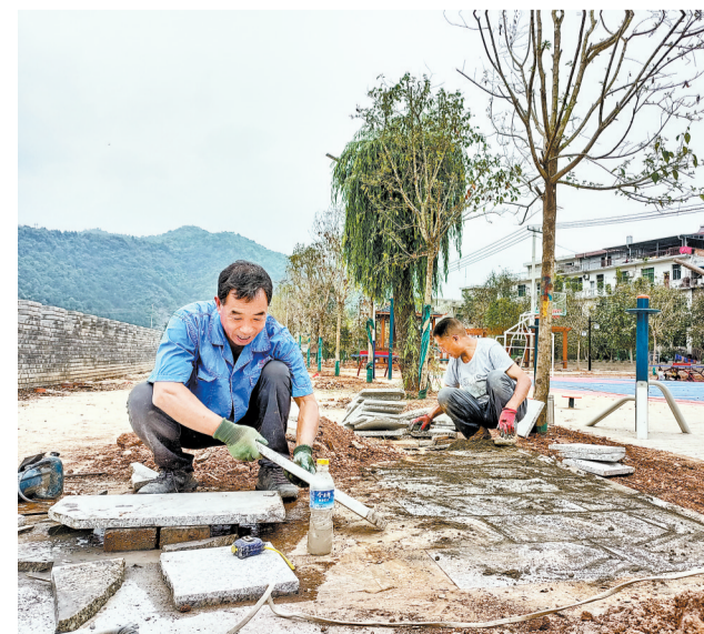
9月17日,在丹凤县武关镇武关村,工人正在进行文化广场的收尾工程。这是武关镇提升城镇品质、满足群众文化娱乐需求的一项民生工程,预计投资150万元,建成后的广场有文艺演出广场、篮球场、健身广场以及休闲长廊等,将满足群众多样化的文化需求。(本报记者 杨 鑫 摄)
