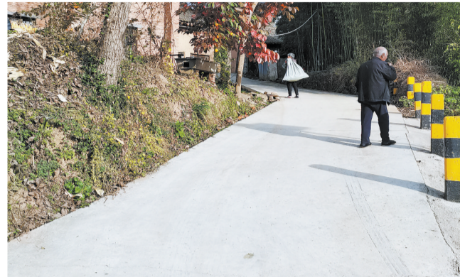
整修后的 南司组岔路通 到村民家
