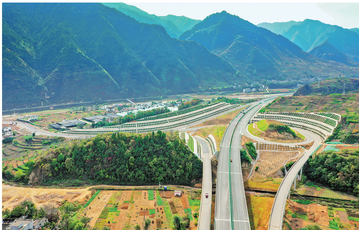
丹宁高速公路丹凤至山阳段项目，属于G4015丹（凤）宁（陕）高速公路东段，是陕西境内横贯秦岭南麓的一条重要东西向联络线。目前，项目路基桥隧工程已完工，路面工程正在加紧建设，确保11月底具备通车条件。图为丹宁高速丹凤县竹林关枢纽立交。（本报记者 米子扬 摄）
