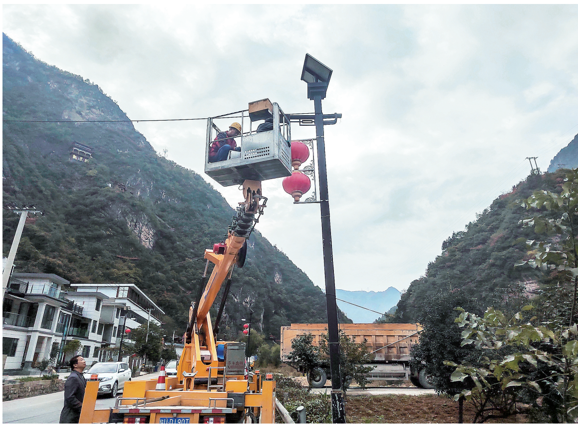
近日,柞水县溶洞景区管理处组织人员对景区内三十八盘提升路路灯及石壳子街道部分路灯线路进行全面更换,确保居民和游客对景区内三十八盘提升路路灯及石壳子街道部分路灯线路进行安全使用,增强景区的安全性。(本报通讯员 罗来宏 摄)
