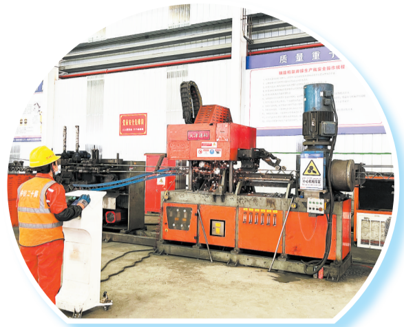
西十高铁商洛轨枕场全自动数控钢筋架焊生产线,施工人员通过操控智能机械,将放线、矫直、弯曲成型、焊接、集料一次完成。
