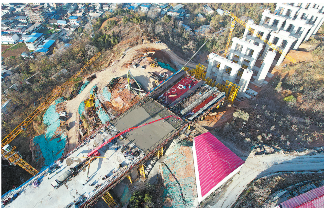
12月7日，随着最后一方混凝土注入梁体，西十高铁（陕西段）全线方量最大的支架现浇道岔连续梁顺利浇筑完成，标志着西十高铁建设取得突破性进展，为后续无砟轨道的铺设奠定了坚实的基础。（本报通讯员 范依楠 摄）
