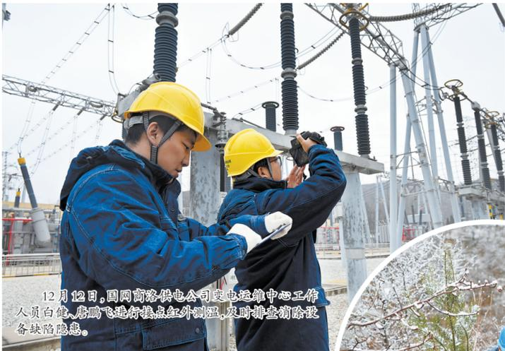
12月12日，国网商洛供电公司变电运维中心工作人员白健、唐鹏飞进行接触点红外测温，及时排查消除设备缺陷隐患。
