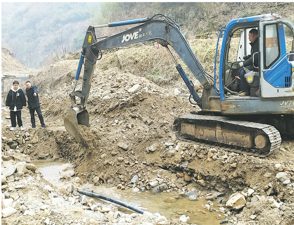
二〇二三年十二月二十九日,丹凤县武关镇枣园村正在建设安全饮水水管道。据悉,该村有三百多米供水主管道被洪水冲毁,枣园村投入人力和物力建设供水主管道,解决近千人的饮水难题。(本报记者 贾书章 摄)
