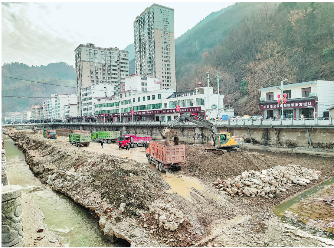
1月5日，镇安县县河水体景观工地一派繁忙施工的景象。为美化城市景观、提升市民休闲娱乐的幸福感和获得感，镇安县利用枯水期加快县河水体景观施工，力争在春节前完工。（本报通讯员 杨建东 摄）
