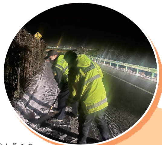
工作人员正在清理福银高速路秦岭隧道段中分带内的积雪
