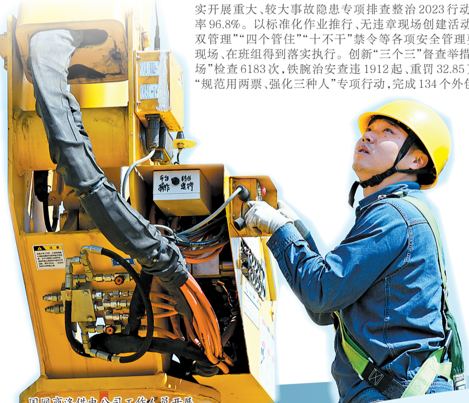
国网商洛供电公司工作人员开展配网不停电带电作业,消除线路缺陷隐患,保障群众清凉度夏。
