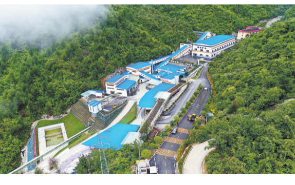
镇安镇产业园一期鼎丰矿采选项目
