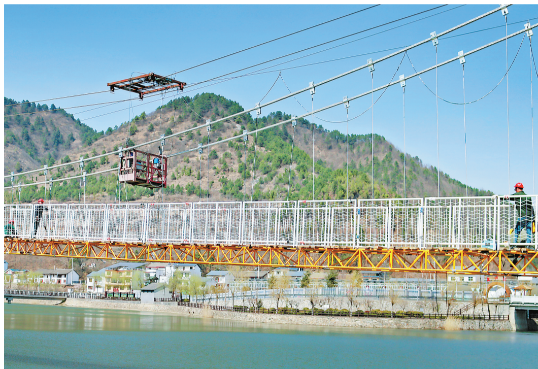
3月22日，工人正在丹凤县富源镇河口村修建银河便民桥。据了解，该桥长70m，净宽1.5m，是一座悬索桥，总投资120多万元，预计一周后竣工，建成后将进一步完善该镇基础设施建设，方便群众出行。同时，构建河口村岭乐园配套环形健身观光线路，促进农旅融合发展。（本报通讯员 王盈琳 摄）
