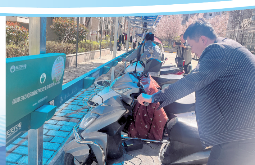
为彻底杜绝电动自行车飞线充电、入室充电，山阳县加快推进充电桩建设。
