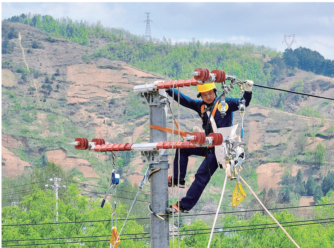
4月16日,国网山阳县供电公司城区中心供电所员工汪鹏在交流110千伏色河变10千伏162元子街线015号杆—冯家湾3号支线002号杆开展金具组串、横担安装以及放紧线工作,确保电网安全稳定运行。(本报通讯员 刘文锋 摄)
