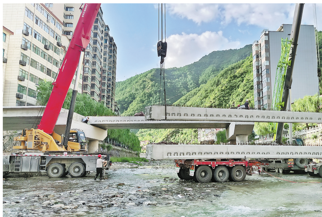
五月十三日，在柞水县城王家沟大桥架梁施工现场，工人正有条不紊地开展架梁工作。据了解，王家沟大桥横跨乾佑河，长约五十四米，宽十二点五米，总投资五百六十四万元，建成后将成为柞水县东西两岸的通道，方便两岸居民出行。（本报通讯员 詹诗涛 摄）
