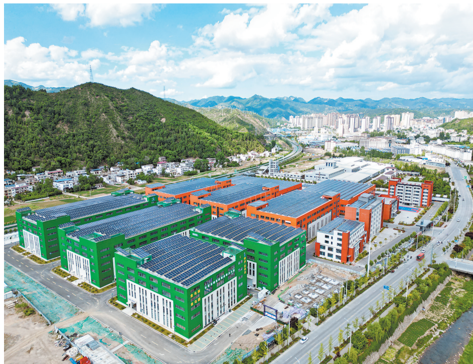
山阳高新区已建成标准化厂房26万平方米,拥有规上企业39家,高新技术企业19家、科技型中小企业65家。图为山阳高新区电子信息产业园。
