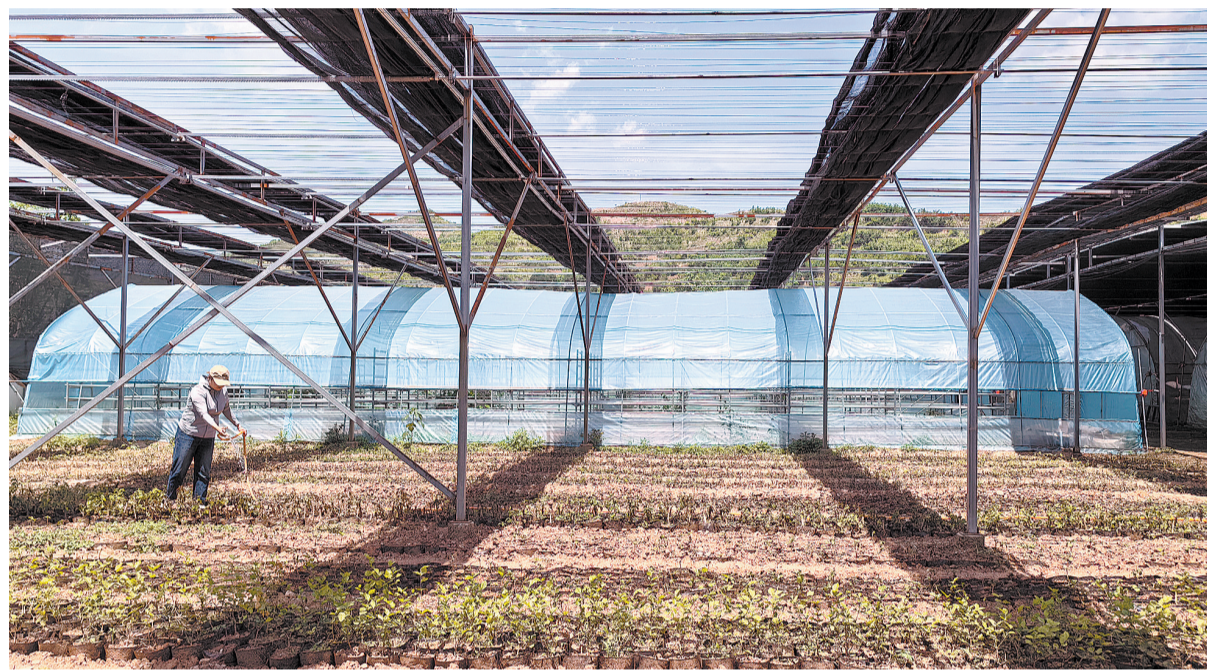
5月16日,丹凤县商镇桃园社区的一位村民正在花卉大棚里浇水。据了解,这个花卉大棚为香菇大棚改造而成,是2024年度桃园社区“千万工程”示范村产业发展项目的一部分。该项目将把原来桃园香菇产业园的10个香菇大棚改造成花卉大棚,并新建2座气调库及配套设施,项目计划总投资200万元,由村集体经济组织管护运营,预计年收入18万元左右,盈余净收益部分用于所有股民分红,壮大集体产业,带动群众增收。(本报记者 胡蝶 摄)
