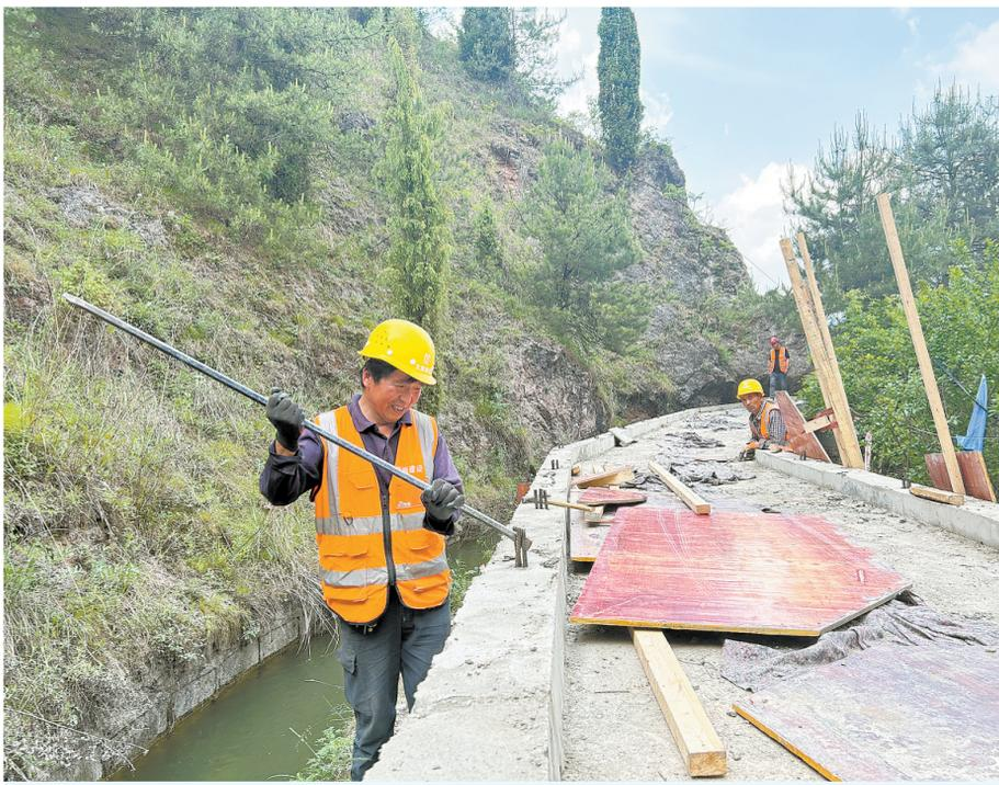
5月14日,工人正在洛南县洛惠渠保安段修建检修步道,以方便今后对老旧、破损水渠进行修复。自1958年修建至今,洛惠渠先后经历了多次改线、修复,干渠全长65公里,灌区范围涉及保安、永丰、四皓、城关4个镇(街道),为沿线群众的生产生活提供了极大便利。(本报记者 肖云摄)
