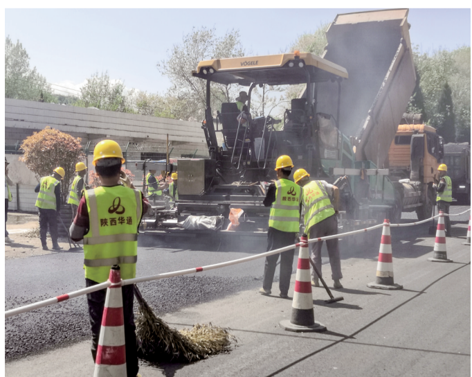
由市公路局拌合厂承建的2024普通国省干线养护大中修工程国道312构峪口至小商塬段目前进展顺利。该工程全长21.84公里,总投资约3200万元,计划6月底完工投入使用。图为5月17日摊铺沥青路面的施工现场。(本报通讯员 杜妍 摄)
