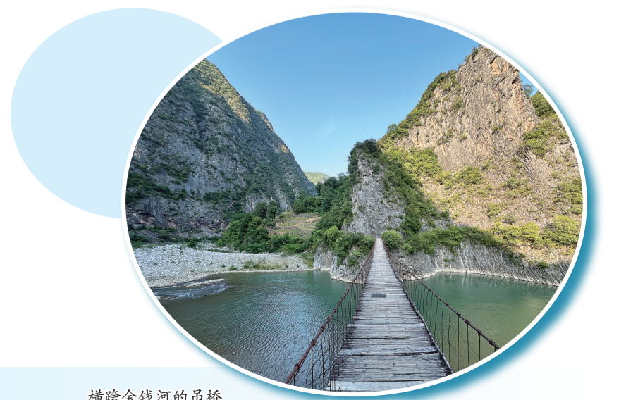
横跨金钱河的吊桥
