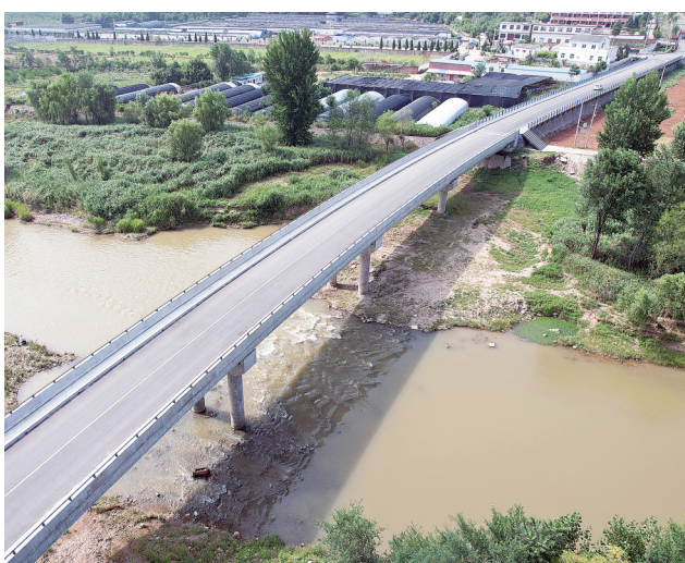
近日,丹凤县万湾丹江大桥危改拆除重建建成通车。该桥位于棣花镇万湾村,南接棣月公路,北连312国道,全长135.58米,桥面宽10米,采用三级公路技术标准,提高了大桥荷载能力。(本报通讯员 李莉 摄)
