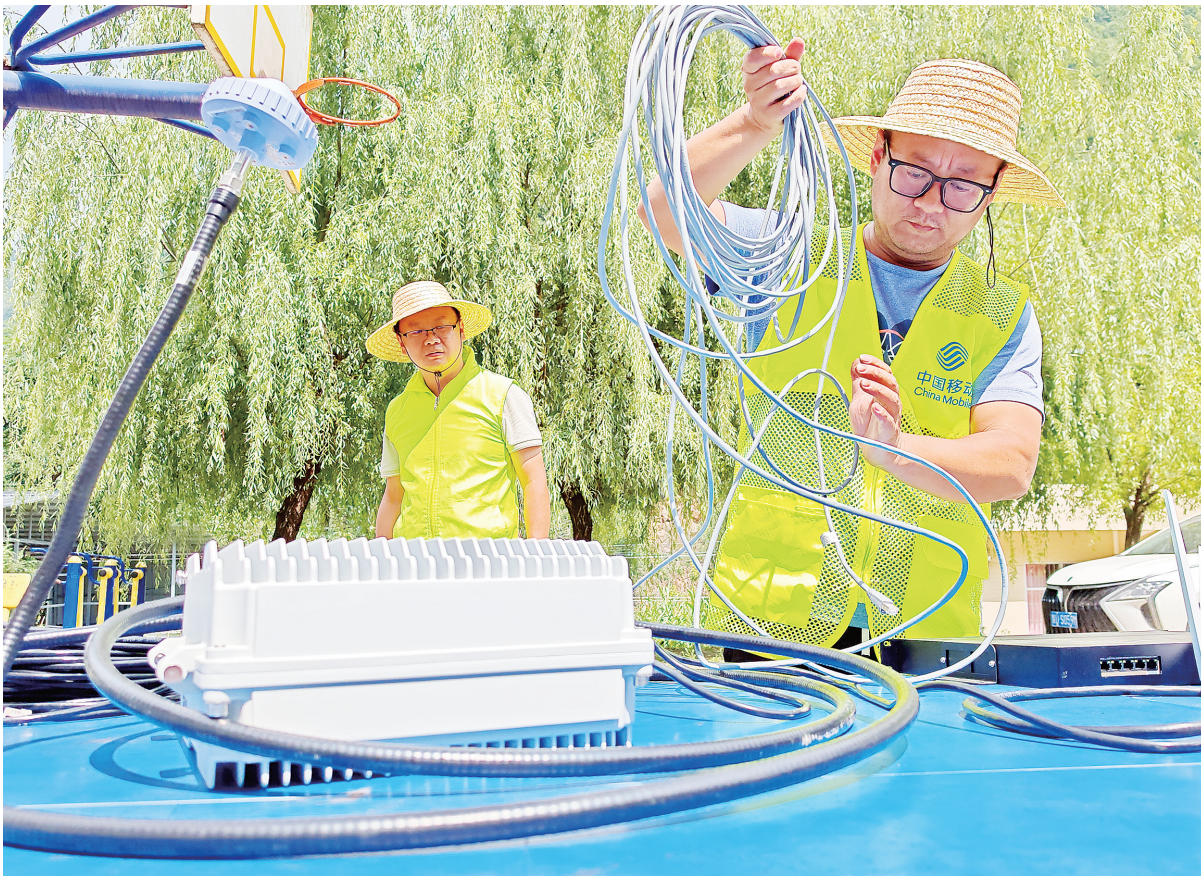
7月24日,面对暴雨导致的电力及光缆受损,中国移动公司山阳分公司在山阳县色河铺镇屈湾村安装卫星通信设备,为抗洪救灾提供应急通信保障。(本报见习记者 杨若阳 摄)
