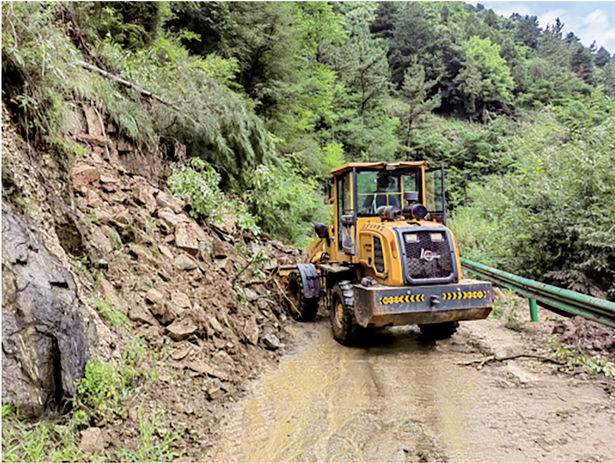
近期,持续强降雨导致丹凤县棣花镇陈家沟村苗组发生多处滑坡和塌方,道路交通受阻,影响群众生产生活。得知情况后,中国能源建设集团西北电力建设工程有限公司积极支持和参与陈家沟村的防汛抢险工作,向陈家沟村捐赠了价值3100元的物资,而且调集项目施工工地的挖掘机、装载机等,全力开展防汛抢险工作。(本报通讯员 刘伊培 摄)
