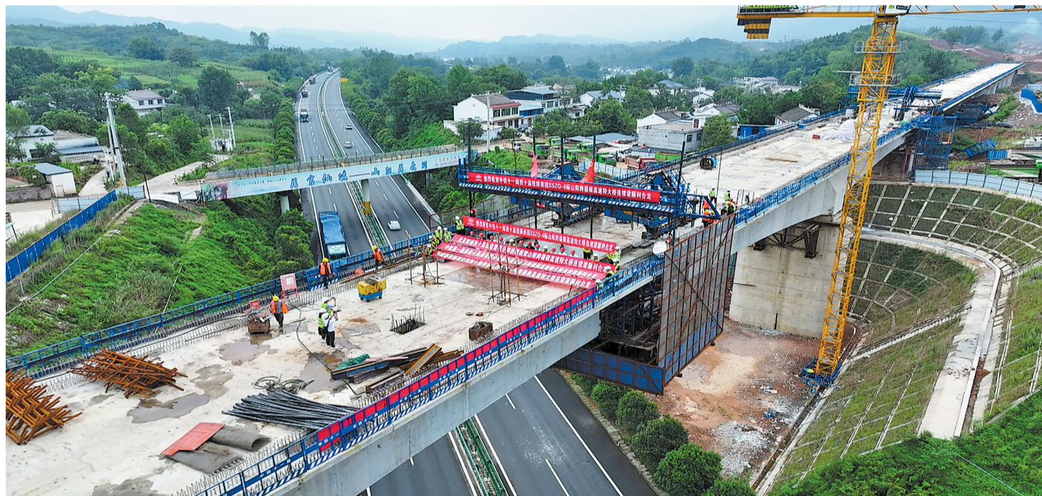
8月16日，随着最后一立方米混凝土浇筑完成，由西成客专陕西公司建设管理、中铁十一局承建的西十高铁陕西段重难点工程——山阳跨福银高速特大桥实现中跨合龙，标志着西十高铁建设取得新突破，为全线如期建成通车奠定了坚实的基础。（本报通讯员 申亚洲 摄）
