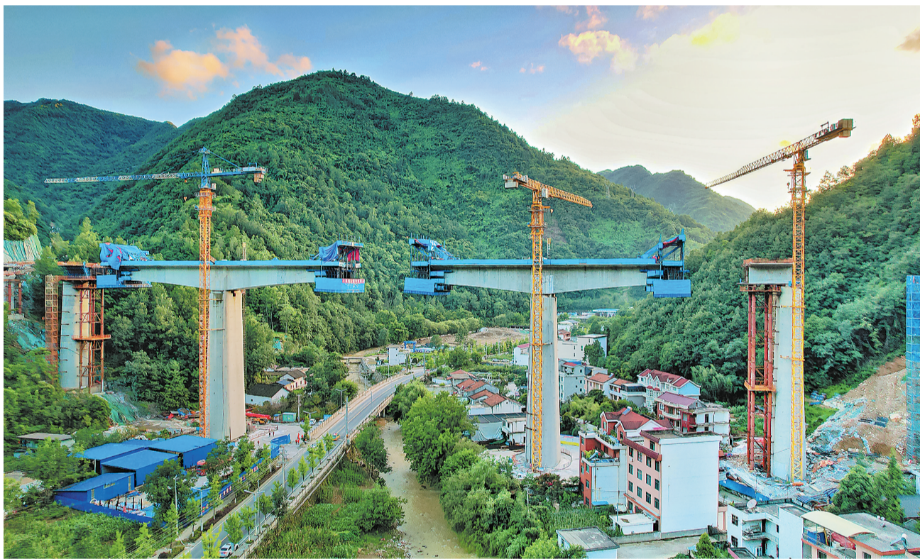
8月20日，西康高铁镇安铁沟西口特大跨路高架桥合龙。西康高铁线路自规划西安东出站南端引出，跨越沙河，穿越秦岭，经过柞水、镇安、旬阳，接入规划安康西站，计划建设工期5年。西康高铁建成通车后，将大幅缩短关中城市群与陕南秦巴山区的时空距离，改善沿线地区客货运输服务水平。（本报通讯员 杨建东 摄）
